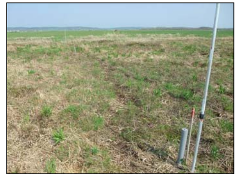
2012年地下水観測管設置状況
